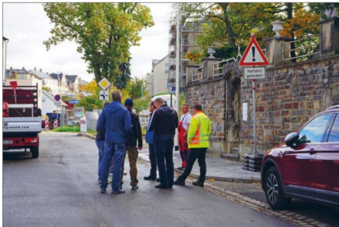
Bauabnahme vor erfolgter Straßenfreigabe am 6. Oktober. Foto: Stadt Glauchau
