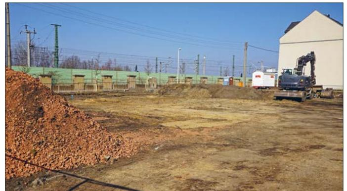
Nach Abriss von Garagen und Baumbestand erfolgte 1.100 m<sup>3</sup> Erdaushub, 200 m Entwässerungsleitungen wurden gelegt und die Fläche geebnet. Foto März 2022
