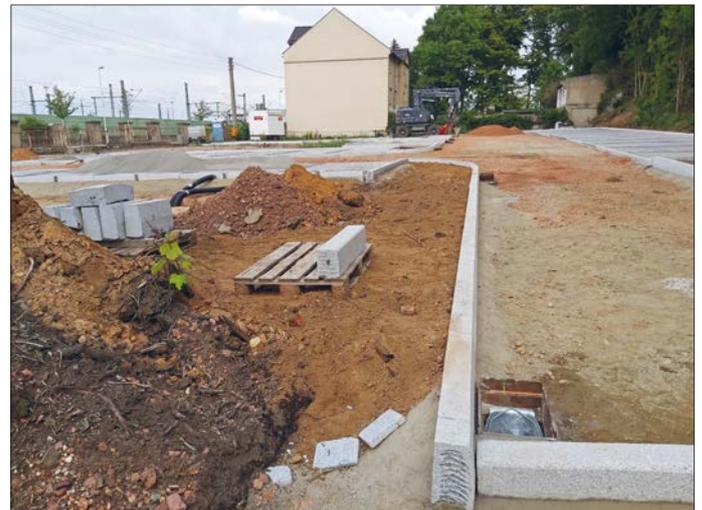
Im August: Einbau niveaugleicher Borde zwischen Parkständen und Fahrbahn.
