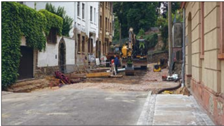
Ausbau des unteren Teilstücks Agricolastraße, Foto: Stadt Glauchau
