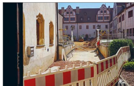
Innenhof Schloss Forderglauchau während der Arbeiten, Foto: Stadt Glauchau
