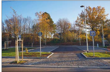
Der fertiggestellte Parkplatz kurz vor Freigabe, Foto: Stadt Glauchau
