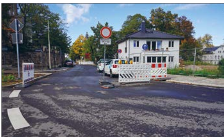
Sanierter Kreuzungsbereich Rudolf-Breitscheid-Straße/Chemnitzer Straße, Foto: Stadt Glauchau
