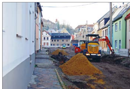
Aufnahme vom November 2022 im Zuge des grundhaften Ausbaus, Foto: Stadt Glauchau
