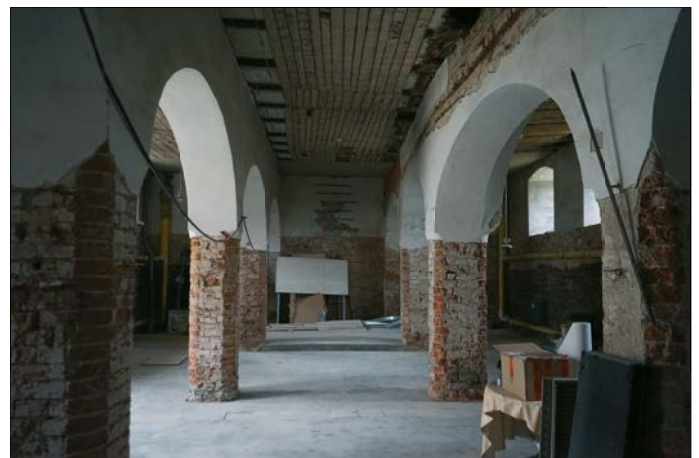
Der Alte Marstall wird bis Ende 2026 denkmalgerecht saniert. Fotos: Stadt Glauchau
