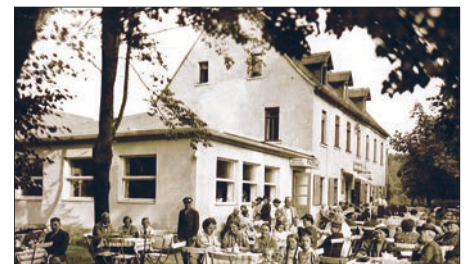
Das einstige Forsthaus vor dem Abriss.
