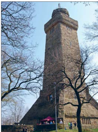
Glauchaus Wahrzeichen – der Bismarckturm – ist schon von weitem sichtbar. Das öffentliche Interesse zum ersten Tag der Öffnung nach den Sanierungsarbeiten war groß.
