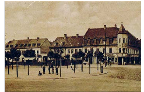
Das Haus in der Mitte des Fotos zeigt die Thomas-Schmiede.
