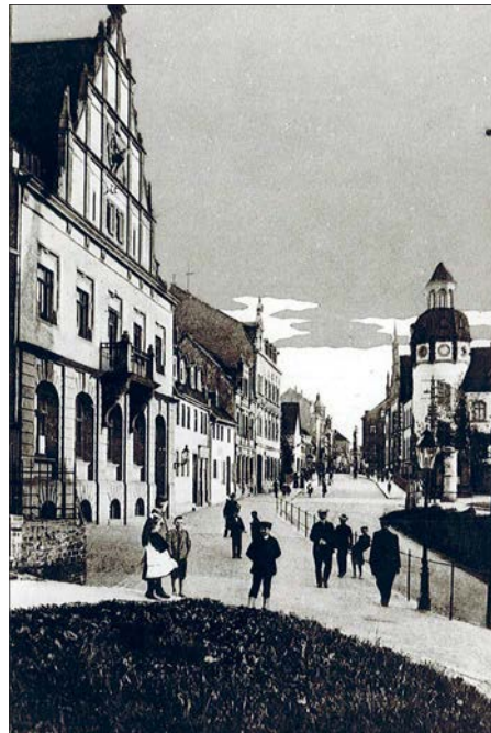
Die Leipziger Straße vor den Pflasterarbeiten
