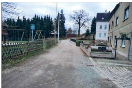
Der Rothenbacher Marktsteig vor Beginn des Bauvorhabens...
