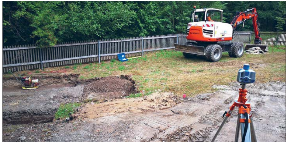
Der Baubetriebshof bereitet das Gelände Spielplatz Ebersbach für die Installation neuer Spielgeräte vor.
