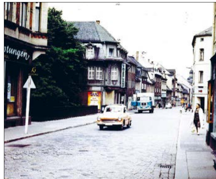
Das erste Haus linksseitig war die komplexe Annahmestelle „Haus der Dienstleistungen“.
