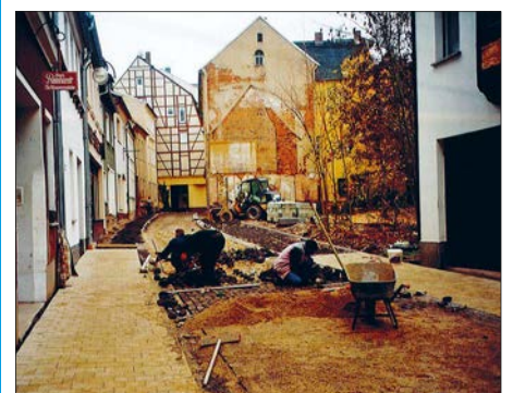
Pflasterarbeiten auf der Nicolaistraße
