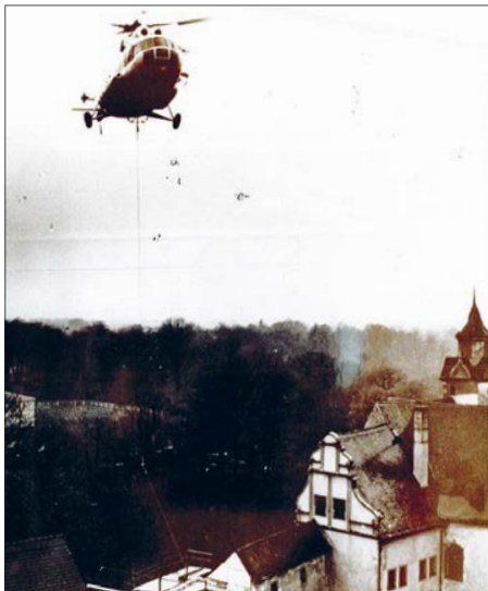
Ein Hubschrauber transportierte schwere Stahlträger.
