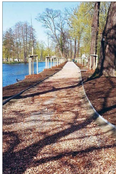
Der Weg kurz vor der Fertigstellung
