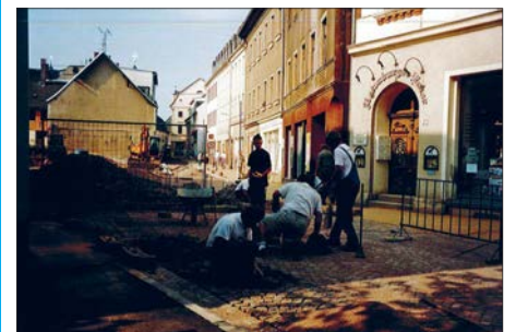
Pflasterarbeiten in der Brüderstraße. Foto: Sammlung W. Hauweisen
