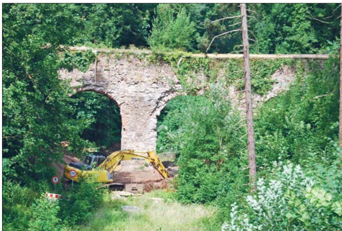
Hirschgrabenbrücke vor dem Abbruch
