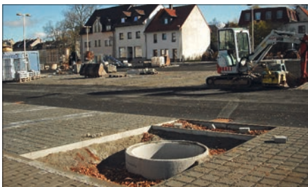
Für den Parkplatz im Bereich Hoffnung/Quergasse mit knapp 100 Stellplätzen wurden u. a. ca. 1300 m 2 Sickerpflaster verbaut. Auch 15 Bäume wurden gepflanzt. Foto: Stadt Glauchau
