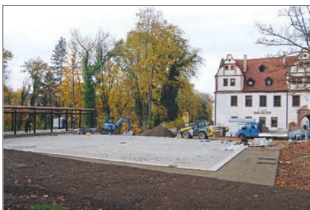
Die Abbildung von Anfang November zeigt den hergestellten Platzbereich mit Einfassung sowie die errichtete Pergola linksseitig. Foto: Stadt Glauchau
