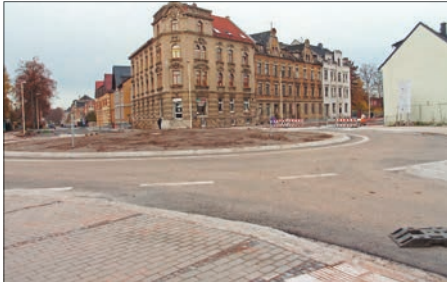
Der für den Bau des Kreisverkehrs notwendige Platz war durch den Abriss des leerstehenden Eckhauses und einer Tankstelle geschaffen worden. Foto: Stadt Glauchau
