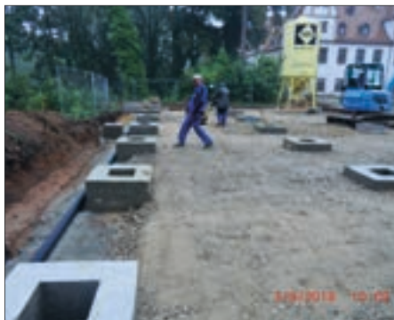
Anfang September konnten die Fundamente für die Pergola gesetzt werden.
