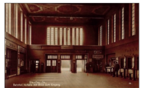
Aufnahme der Vorhalle im Bahnhof Ende der 20er Jahre
