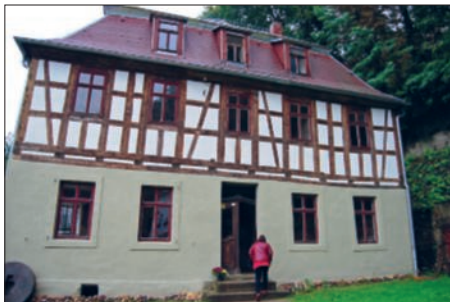
Das unter Denkmalschutz stehende Gebäude Mühlberg 6, Aufnahme vom September 2014
