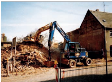
Dem Abriss entlang der Quergasse...
