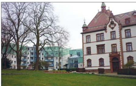
Anbau am Bürgerheim
