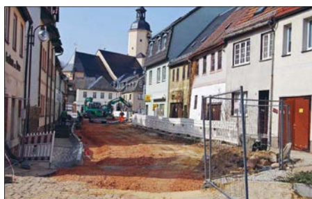
Grundhafter Straßenbau am Zwinger und Schulplatz
