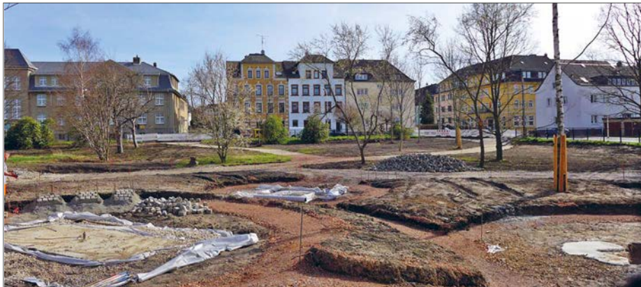
Das im März aufgenommene Bild zeigt bereits die drei neu angelegten Rundbereiche in der Mitte des künftigen Parks. Hier werden bald Sport- und Spielgeräte aufgestellt, die notwendigen Fundamente sind schon vorhanden. Foto: Stadt Glauchau
