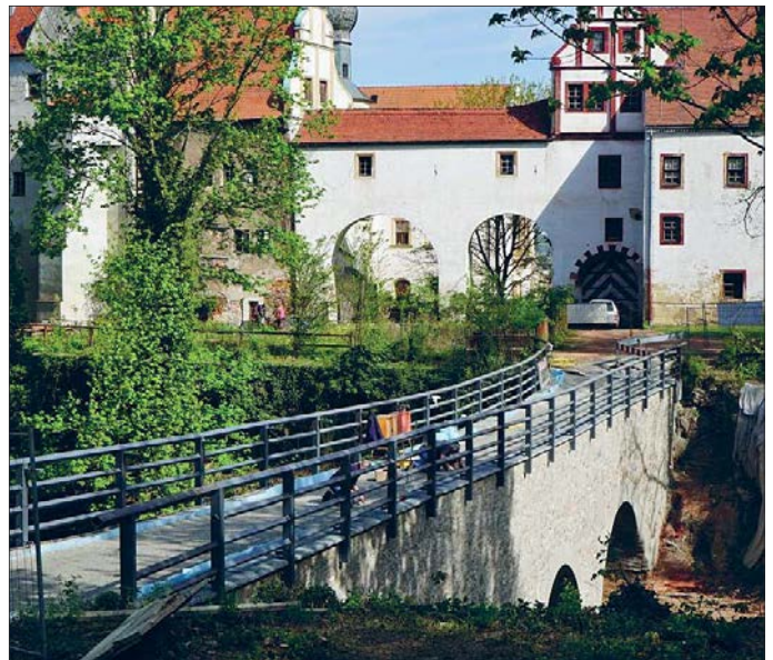
Noch sind die Arbeiten an der Hirschgrundbrücke nicht abgeschlossen.
