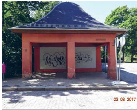
Das Gebäude des ehemaligen Kioskes am Schillerpark vor Beginn der Sanierung...
