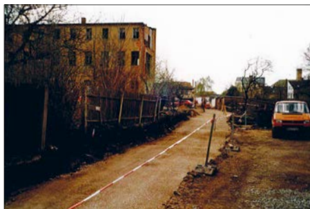
Vorbereitungen für den Bau der Gewerbegasse
