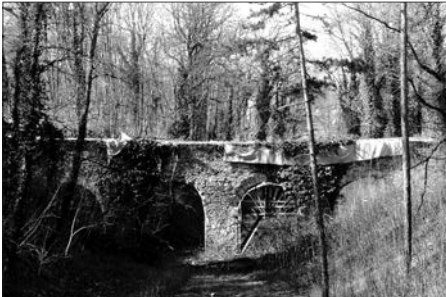
Hirschgrabenbrücke vor dem Abbruch
