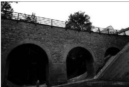
neu errichtete Hirschgrabenbrücke
