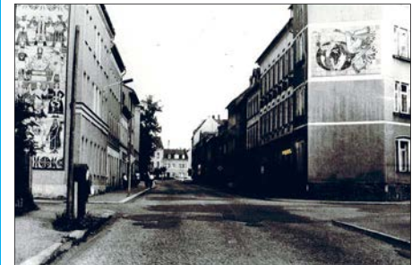
Die August-Bebel-Straße vor der Sanierung.
