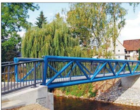
Die neue Brücke ist eine etwa 5 Tonne schwere Stahlkonstruktion.
