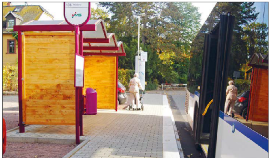
Die Bushaltestelle am Heinrichshof ist bereits barrierefrei umgebaut und planmäßig fertiggestellt.
