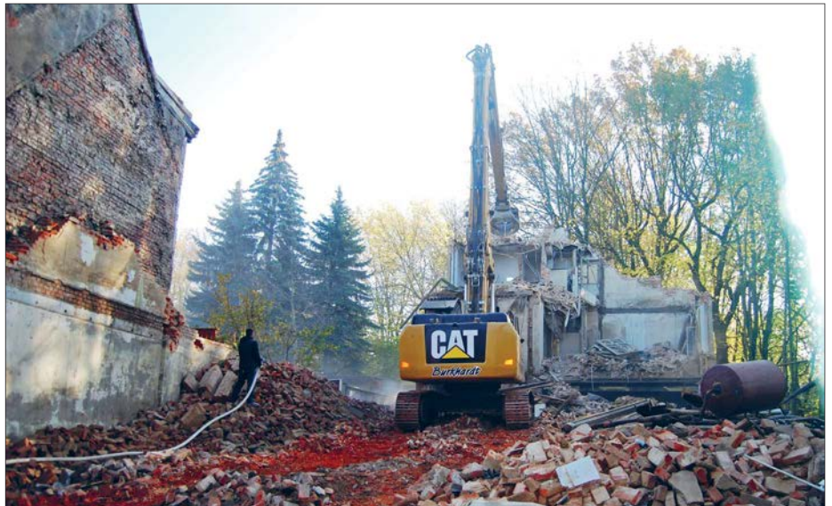
Der Abbruch am Hang zum Äußeren Stadtgraben ist fast vollzogen.
