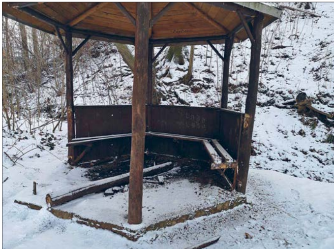
Bei dieser Schutzhütte wurden die Wand ausgebrochen und die Sitzfläche beschädigt.
