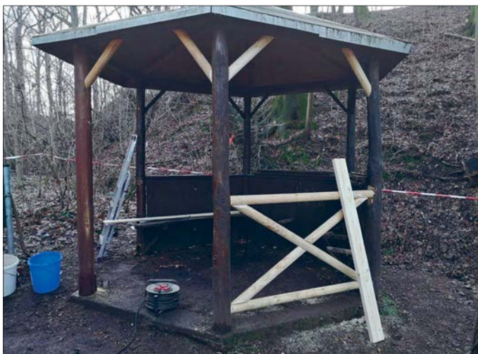
Balken und Wände werden, wie im Bild von Anfang Februar zu sehen, wieder neu angebracht.
