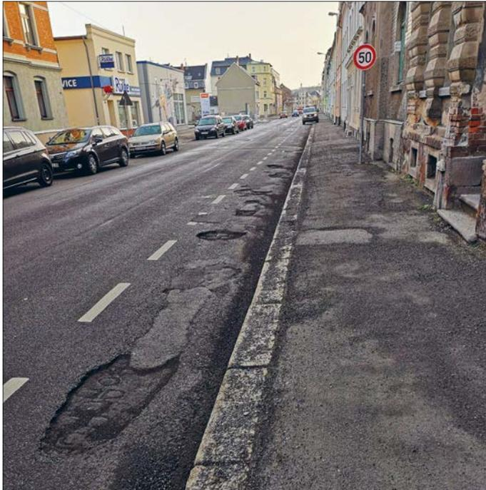
Auch die Auestraße gehört zu den Straßen, die durch langanhaltende Kälte, Schnee und Eis gelitten haben. Für die Reparatur der Schäden muss der Baubetriebshof einiges an Material aufbringen.
