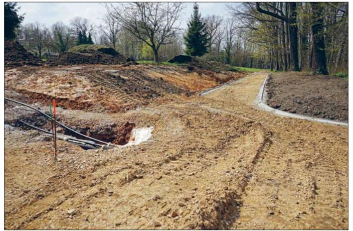
Leerrohre dienen der späteren Stromversorgung und Straßenbeleuchtung. Wege sind mit Stahlbändern eingefasst.
