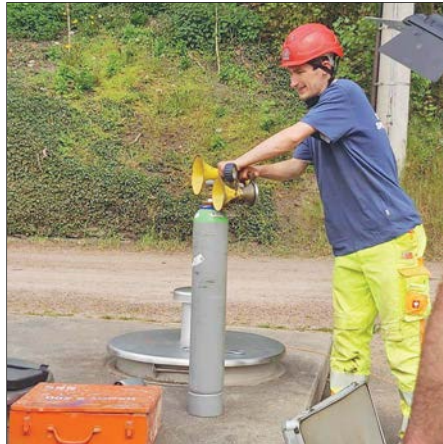
Sprengmeister Neubert installiert die Fanfare.
