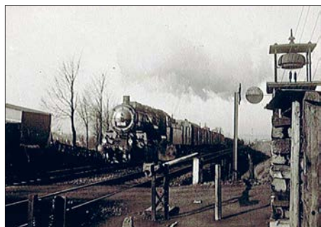
Abbildungen vom Bahnübergang in Niederlungwitz
