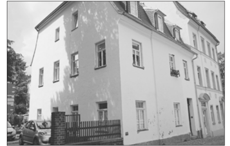
In diesem Gebäude befand sich bis August 1996 der evangelische Kindergarten. Foto: Stadt Glauchau
