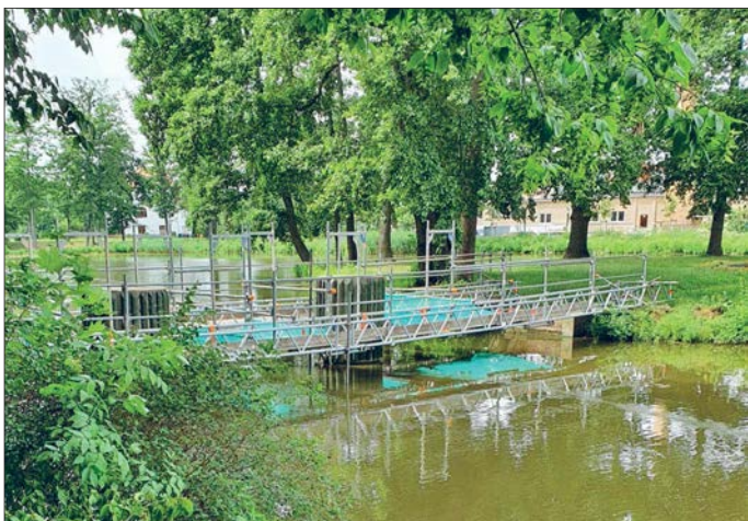
Der alte Überbau ist abgetragen. Aufnahme vom 13.07.2021.
