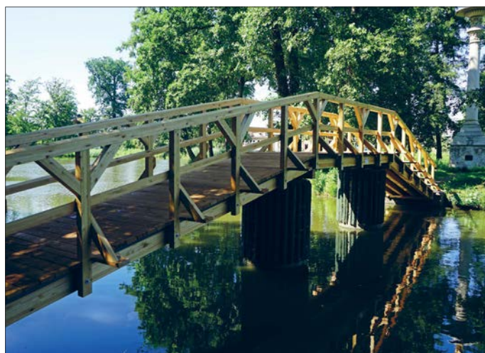
Die fertige Überquerung.
