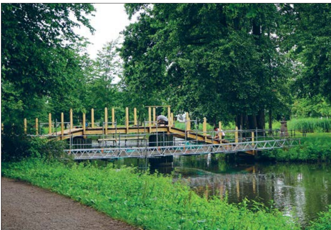
Der neue Überbau wird errichtet. Aufnahme vom 21.07.2021.
