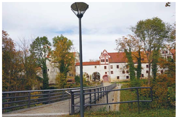
Die neue Hirschgrabenbrücke. Die Anbindungen zur Brücke sind barrierefrei hergestellt. Foto: Stadt Glauchau
