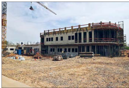
Neubau des Gesundheitszentrums im Rohbau Foto: Mike Hillebrand, Mindwork marketing agency
