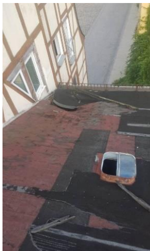
Dach Nicolaistraße 1 – vorher
