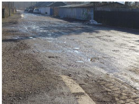
Zimmerstraße - vor Ausbau
