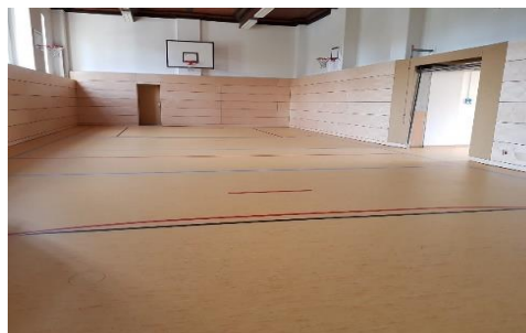
neuer Boden und Prallwand
