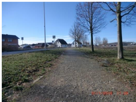
Gehweg Sachsenallee – vor Neubau
