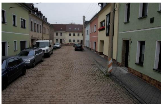
Luisenstraße – vor Ausbau
