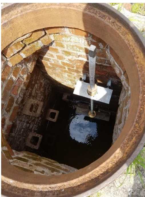
erneuerter Absperrschieber Mühle Schlunzig
