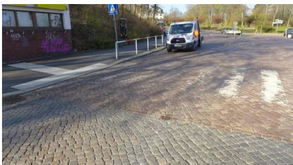
Fußgängerüberweg Rosa-Luxemburg-Straße – vor Sanierung
