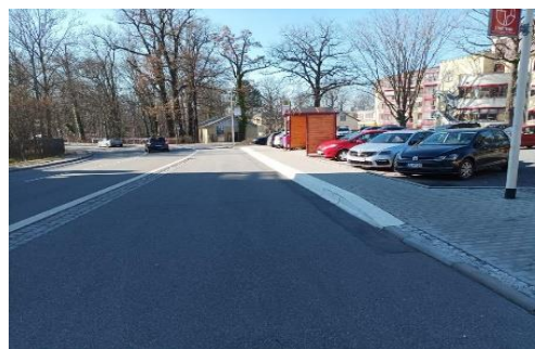
Bushaltestelle Heinrichshof - nach Ausbau
