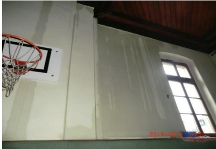
Turnhalle Wände & Decke
