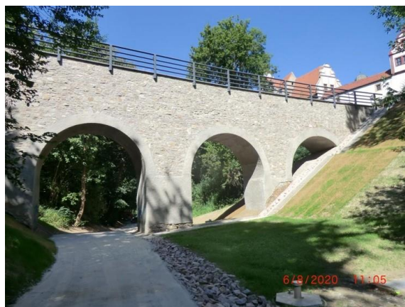
Hirschgrabenbrücke -- nach Sanierung
