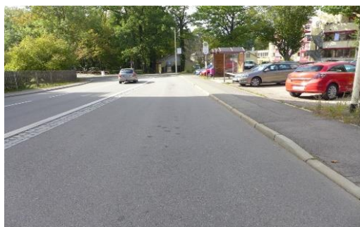
Bushaltestelle Heinrichshof - vor Ausbau
