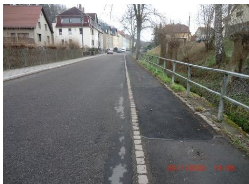
Rothenbacher Straße - vor Ausbau
