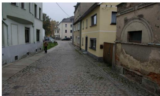
Mittelgasse - vor Ausbau
