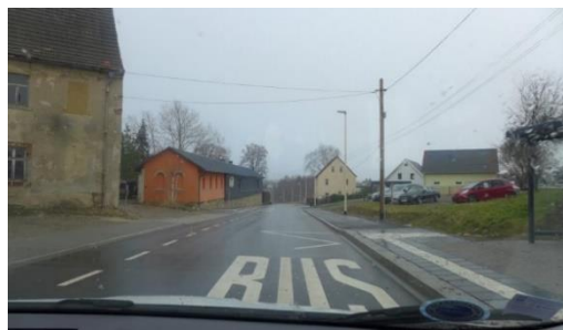
Meeraner Straße – nach Ausbau
