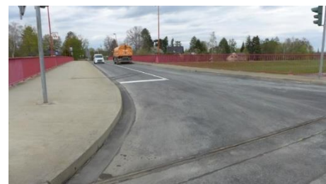
Brücke Waldenburger Straße – nach Sanierung
