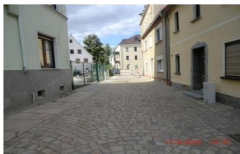
Mittelgasse - nach Ausbau
