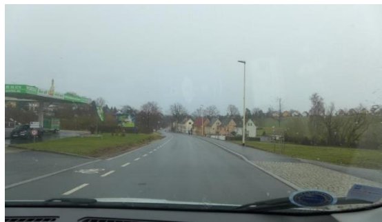
Meeraner Straße – nach Ausbau
