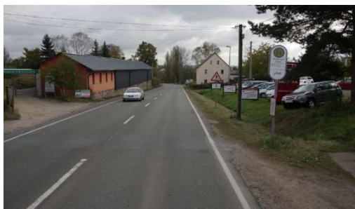
Meeraner Straße – vor Ausbau
