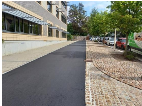
Anlieferspur Gymnasium – nach Ausbau
