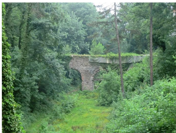
Hirschgrabenbrücke – vor Sanierung
