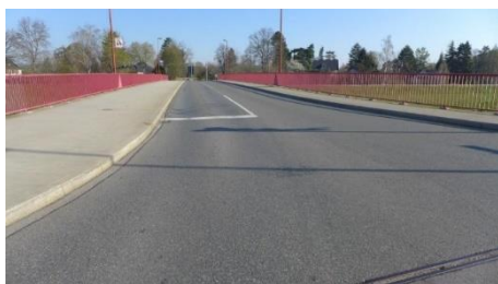
Brücke Waldenburger Straße – vor Sanierung
