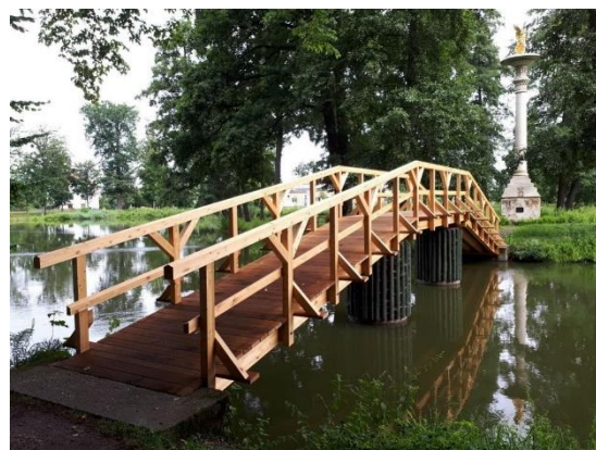
Gründelteichbrücke – nach Sanierung
