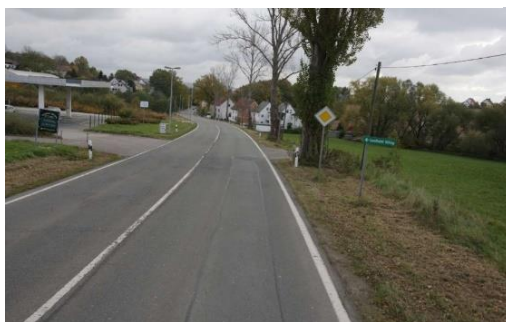
Meeraner Straße – vor Ausbau
