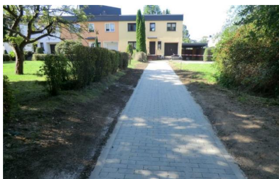
Neu erstellter Gehweg
