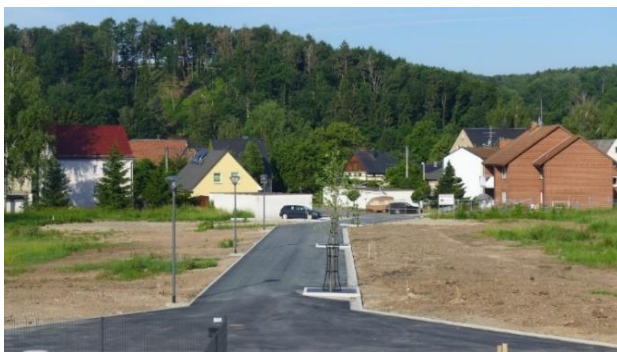
Fertig gestellter Platanenweg Mitte 2021
