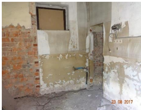
Innenansicht – vor Umbau
