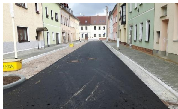
Luisenstraße – nach Ausbau
