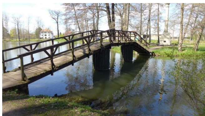
Gründelteichbrücke – vor Sanierung
