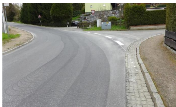
Glauchauer Straße – nach Erneuerung
