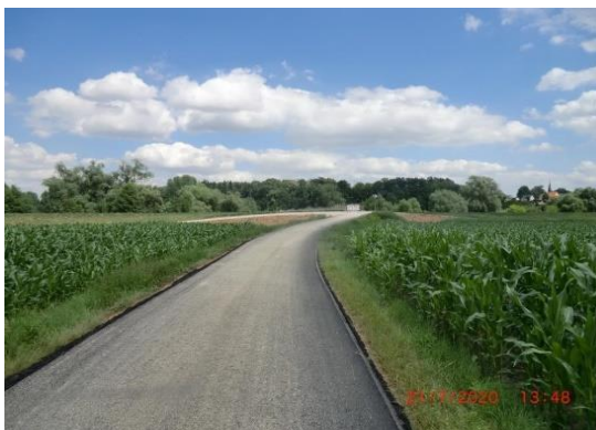
Muldenstraße - nach Ausbau
