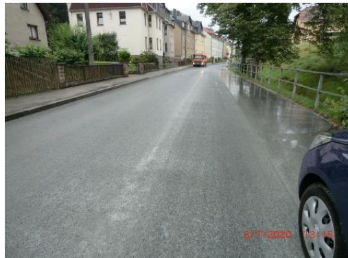
Rothenbacher Straße - nach Ausbau
