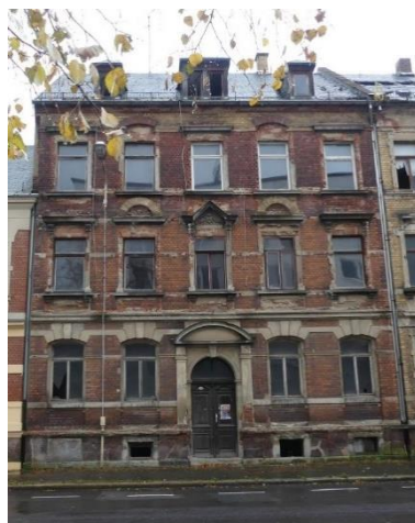
Auestraße 11 und vorher Foto: hdk Ingenieurgesellschaft mbH Glauchau
