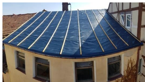
Dach Nicolaistraße 1 – nachher
