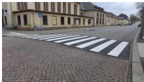
Fußgängerüberweg Rosa-Luxemburgstraße – nach Sanierung
