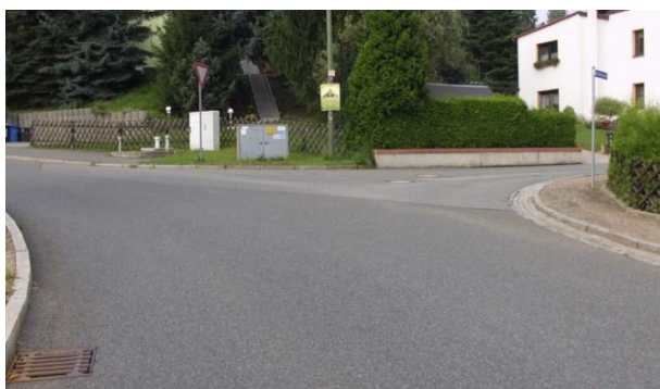
Glauchauer Straße – vor Erneuerung
