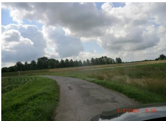
Muldenstraße - vor Ausbau
