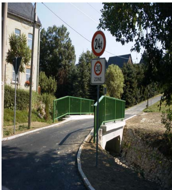
Neubau von zwei Brücken - Am Scheibenbusch
