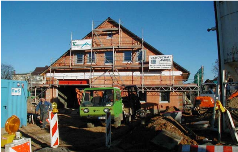
Stand Neubau Feuerwehrgerätehaus - Bauplatz 20.12.04
