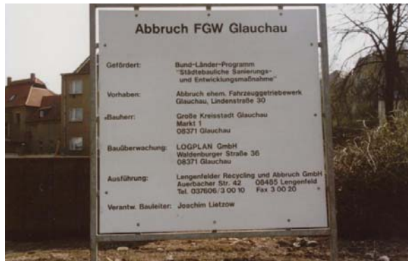
Abbrucharbeiten ehemaliges Fahrzeugtriebwerk
