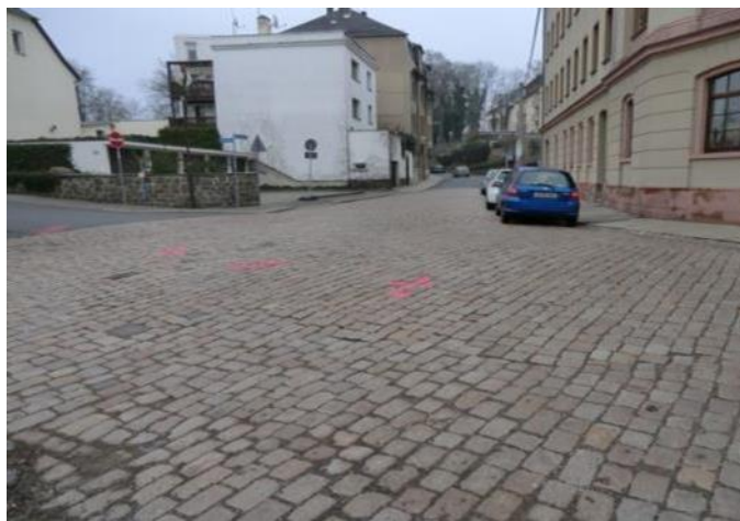
Knotenpunkt Schulplatz / Agricolastraße vor der Sanierung
