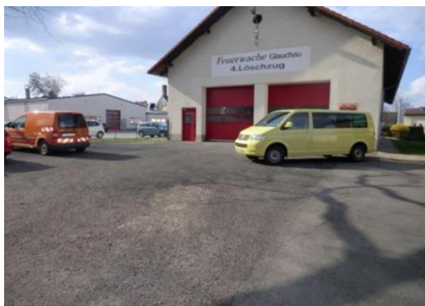
vor der Maßnahme
