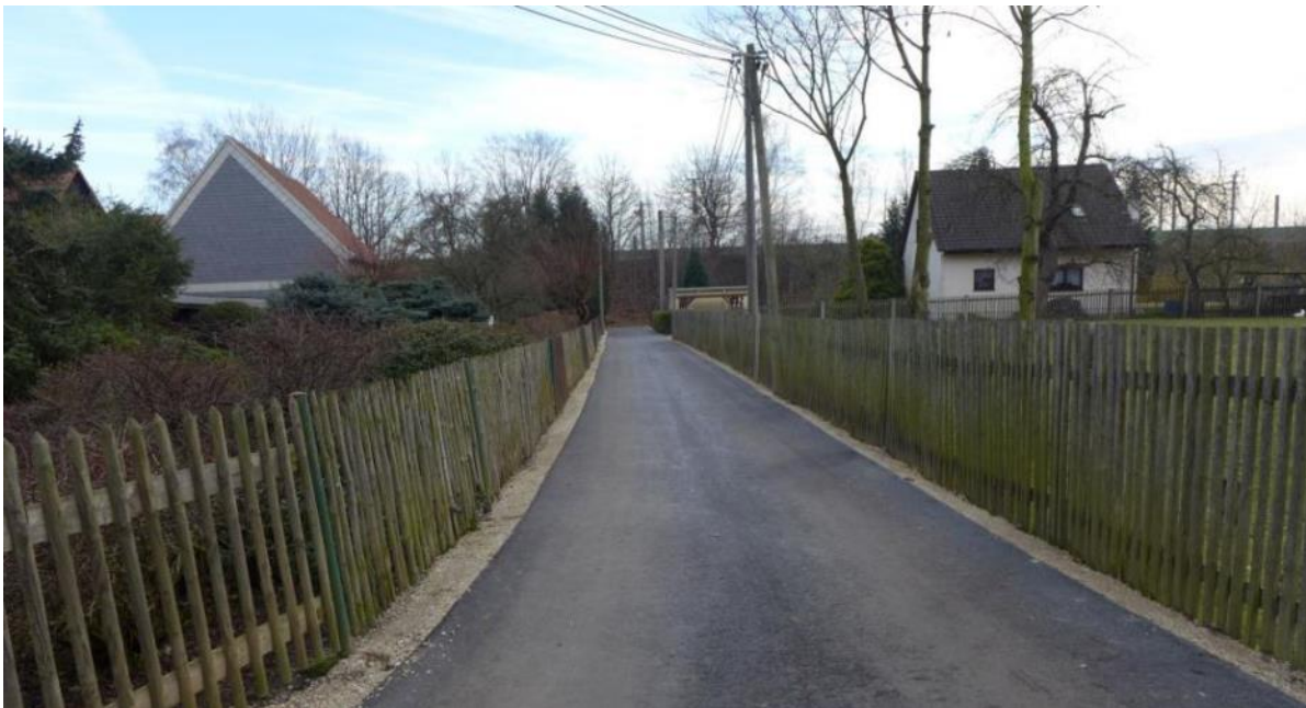
nach der Hochwasserschadensbeseitigung
