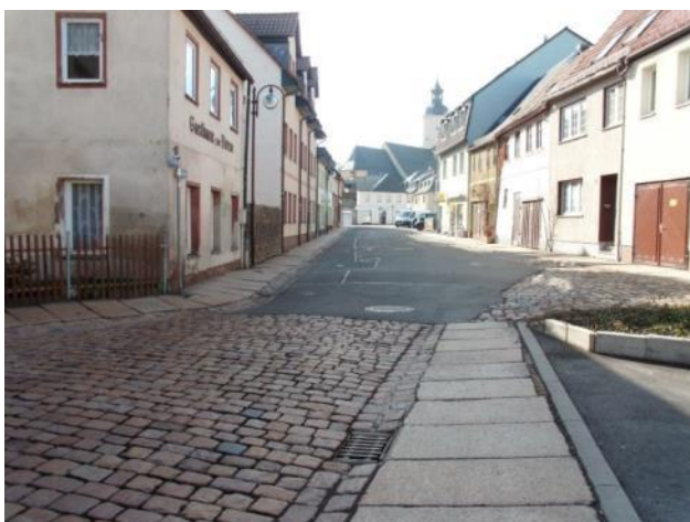
vor der Sanierung Zwinger
