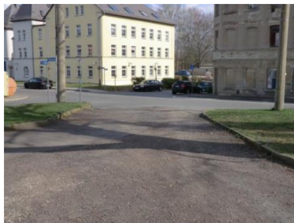
vor der Maßnahme
