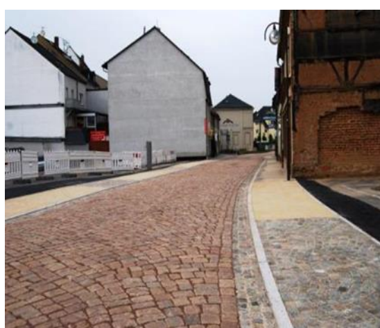
nach der Sanierung Zwinger / „Hellmich-Parkplatz“
