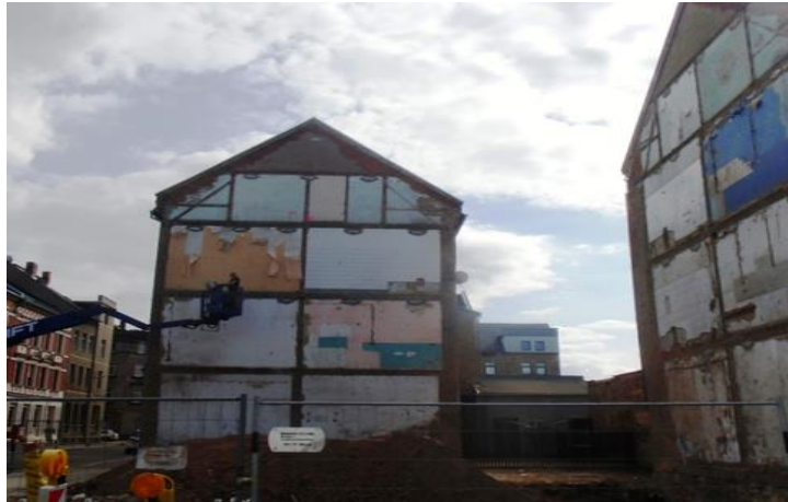
Nach dem Abriss
