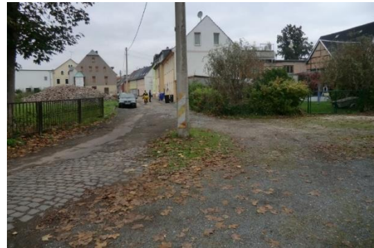
vor dem Bau – Blick Richtung Malzhaus
