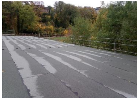
nach der Instandsetzung
