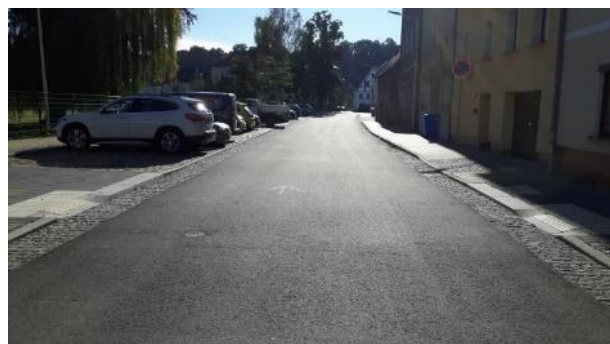
Wehrdigtstraße nach dem Bau
