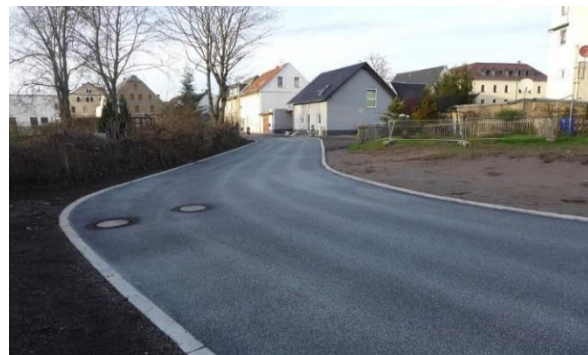
nach dem Bau – Blick Richtung Malzhaus
