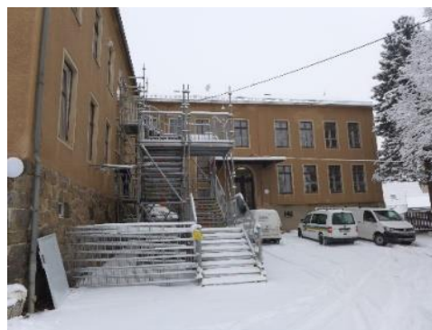
Anbau der Flutttreppe
