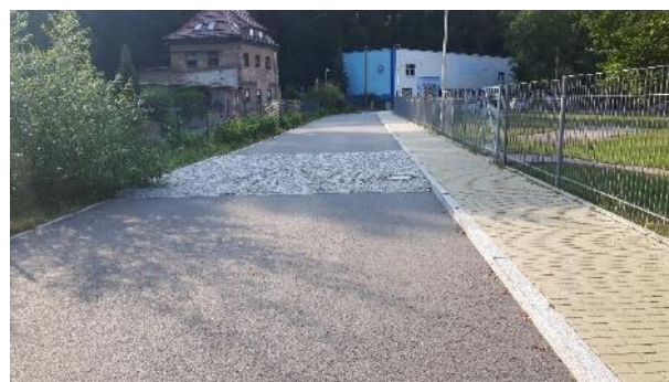
nach dem Bau
