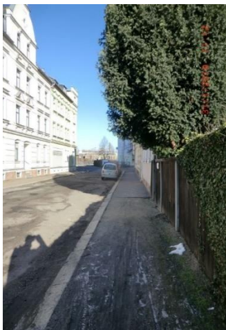
vor dem Ausbau – je nach Witterung teilweise schlammig
