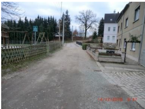
vor dem Ausbau
