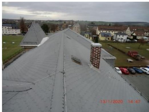
Dach nach der Instandsetzung
