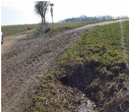
vor dem Ausbau – frei befahrbar
