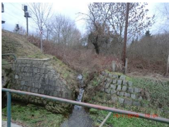
vor der Beräumung
