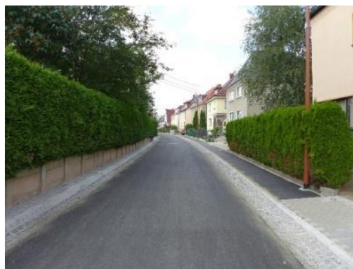
nach dem Bau
