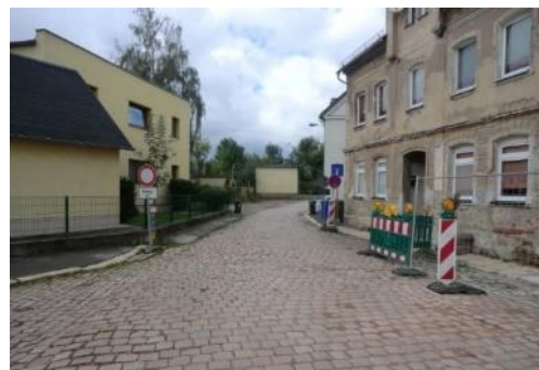
Wehrstraße vor dem Bau
