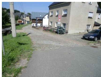
vor dem Ausbau
