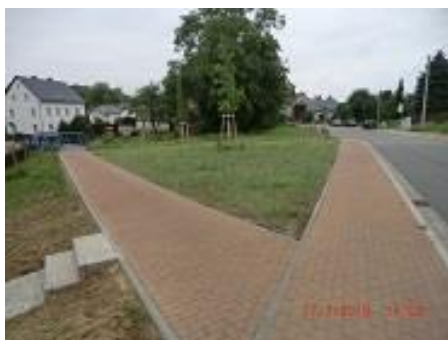
Verfüllung des Mühlgrabens
