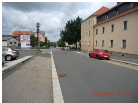
nach dem Bau
