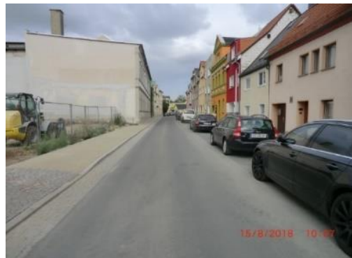
Marienstraße nach dem Bau
