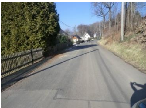
vor dem Bau – Blick Richtung Seiferitzer Weg
