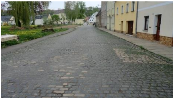
Wehrdigtstraße vor dem Bau
