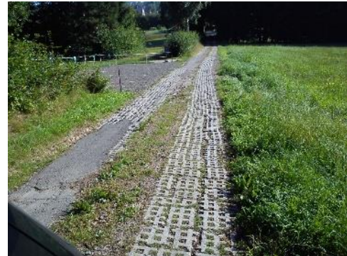
Bergstraße vor dem Ausbau
