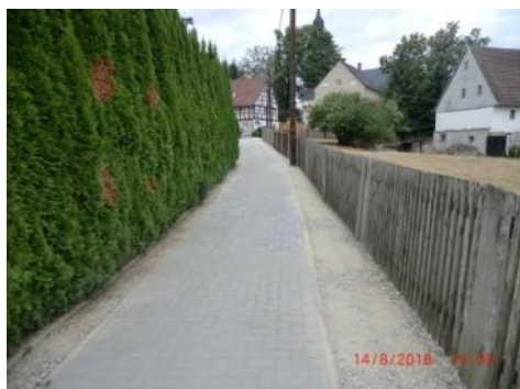
nach dem Bau
