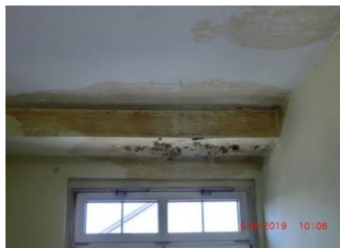
Nässeschäden im Treppenaufgang
