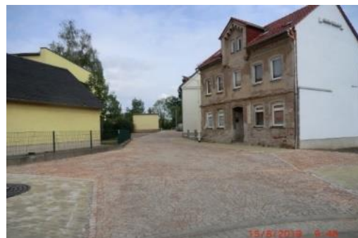
Wehrstraße nach dem Bau
