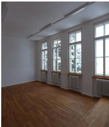
renoviertes Klassenzimmer mit aufgearbeiteten Parkett
