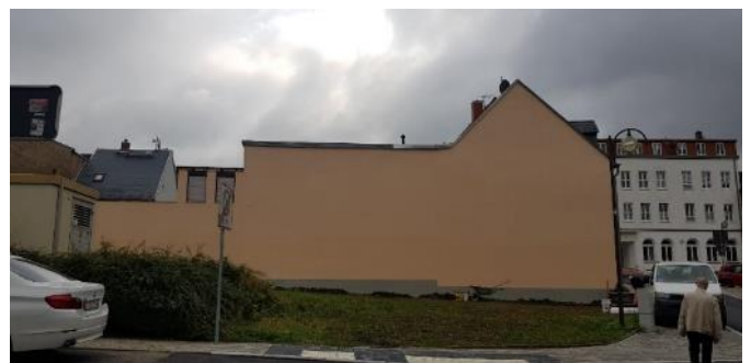
nach dem Abbruch
