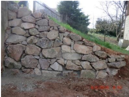
fertiggestellte Stützwand
