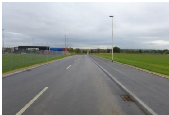
Boschstraße nach Straßenbau
