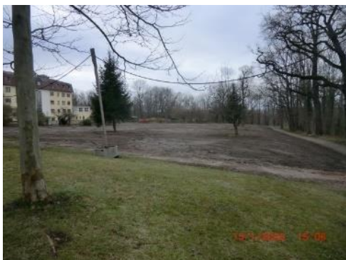
Freifläche nach Abriss
