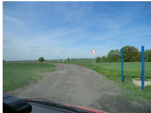
nach dem Ausbau mit Schranke
