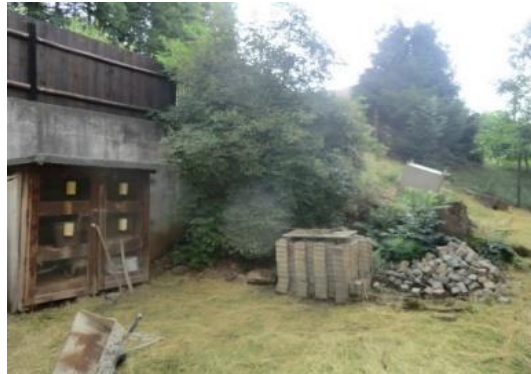
vor dem Bau der Stützmauer
