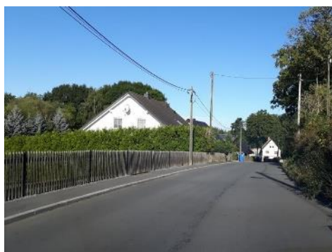
nach dem Bau – Blick Richtung Seiferitzer Weg
