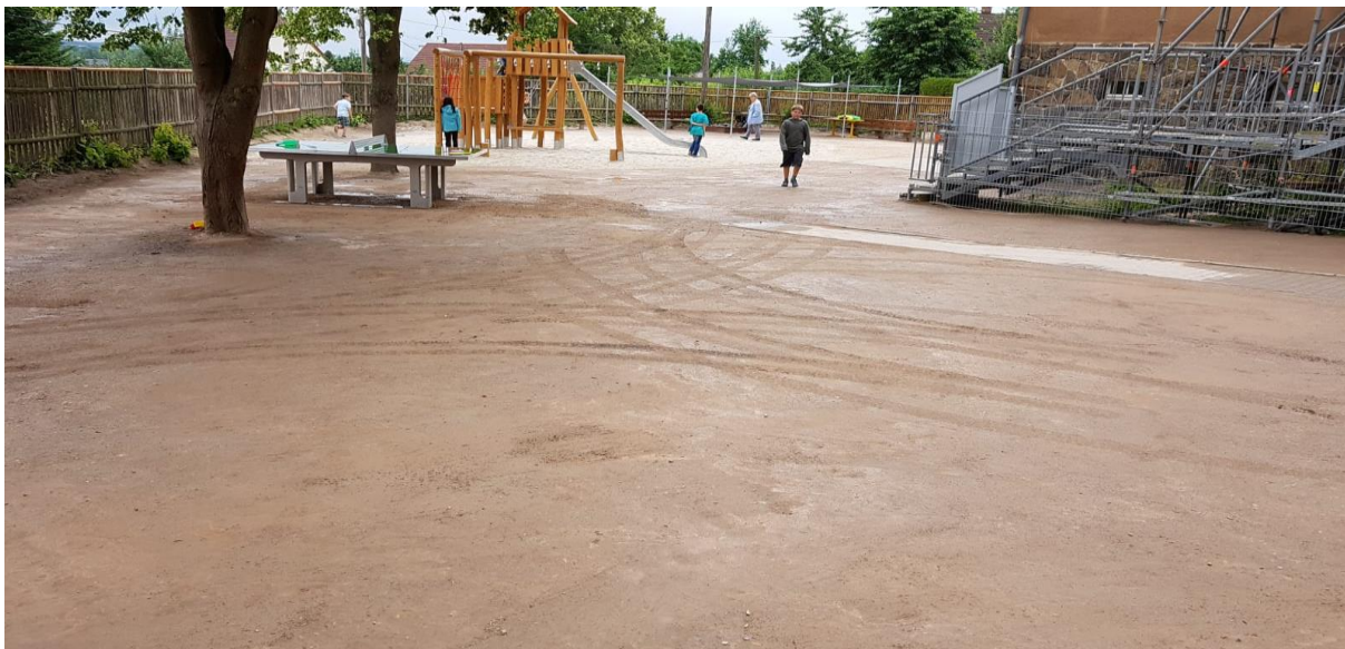
Außengelände nach der Fertigstellung
