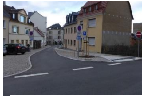
nach dem Straßenbau
