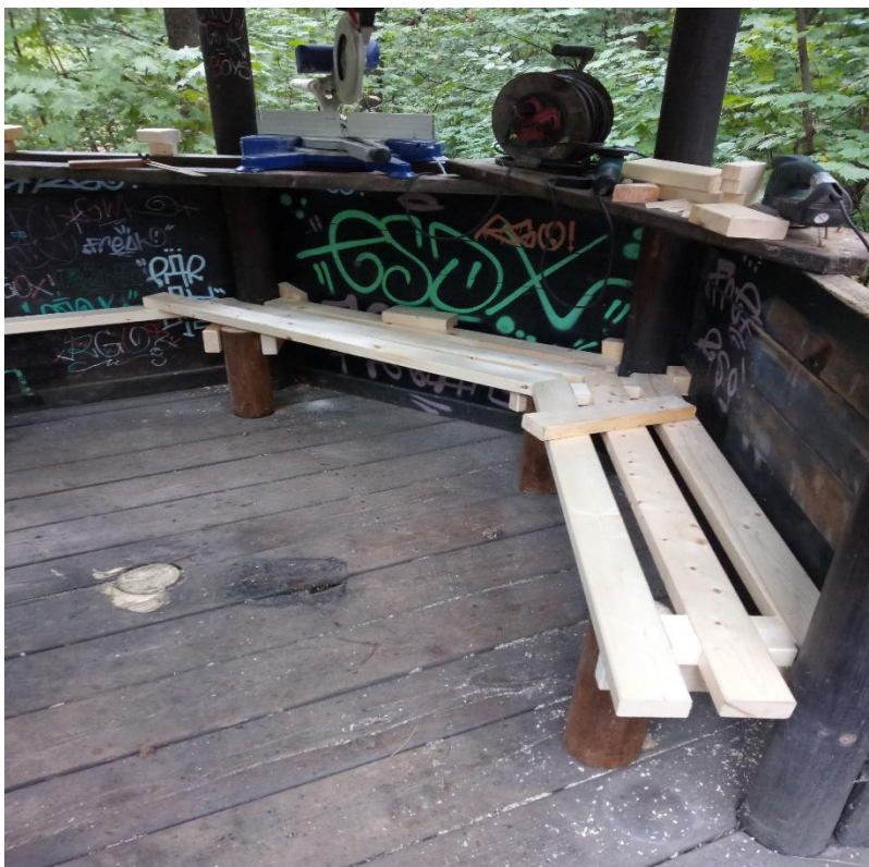
während des Ausbaus
