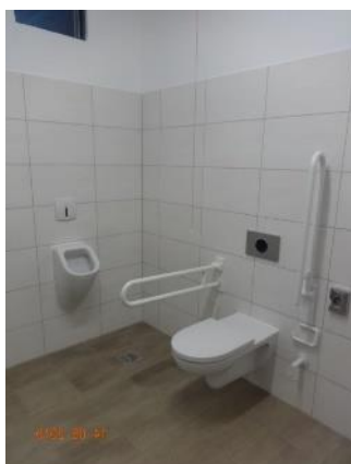
behindertengerechte Toilette nach Umbau
