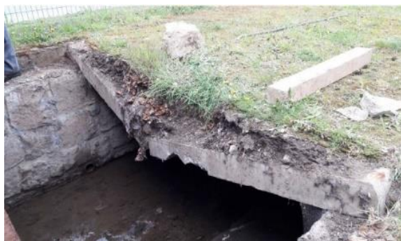
gebrochene Abdeckplatten
